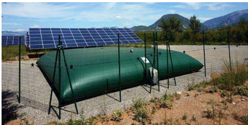
Figure 18 : Exemple de réserve à incendie souple
