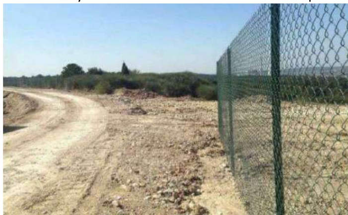
Figure 20 : Exemple de clôture et voie d'accès sur une centrale photovoltaïque
