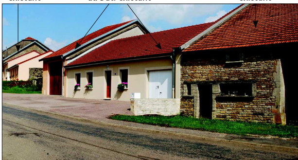
Restauration et construction en dent creuse dans le village de Châtenay-Mâcheron.
