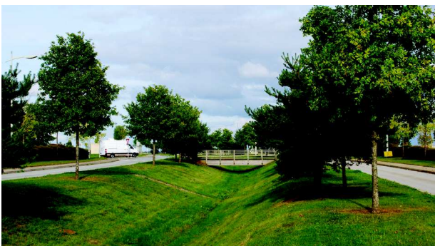
Noue plantée pour gérer les eaux de ruissellement en surface et constituer un espace public de qualité dans le parc d'activités économiques de référence Plein Est, à Chaumont.
