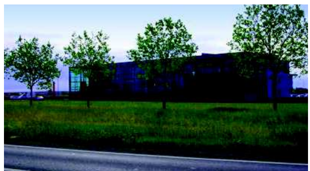
Recul d'implantation des bâtiments par rapport à la voie et mise en scène paysagère (enherbement, alignement d'arbres, absence de clôture...), Parc A10, Blois.
