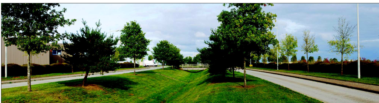
Zone d'activités récente réalisée avec soin (Chaumont) : recul par rapport à la route principale, plantation d'arbres en alignement, gestion de l'eau de ruissellement par des noues enherbées et plantées, architecture contemporaine...
