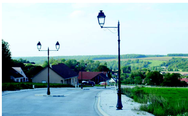
Extension urbaine en cours de construction : lorsque les espaces publics sont essentiellement dédiés à la voiture, leur image est banale et sans qualité.
