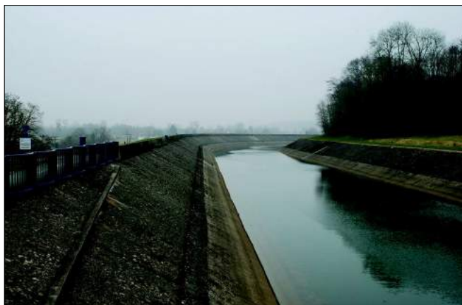
Le canal d'aménée de la Marne à Moëslains
