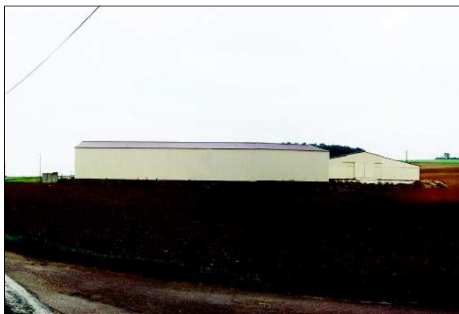
Bâtiment agricole «posé» au milieu des cultures, près de Cusey
