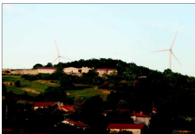
Site éolien lourd d'impact paysager pour la commune de Brachay
