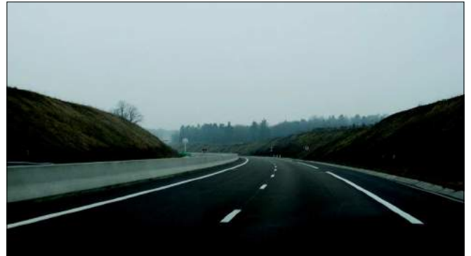
La N 67 près de Chaumont, un ouvrage récent aménagé sans prise en compte paysagère
