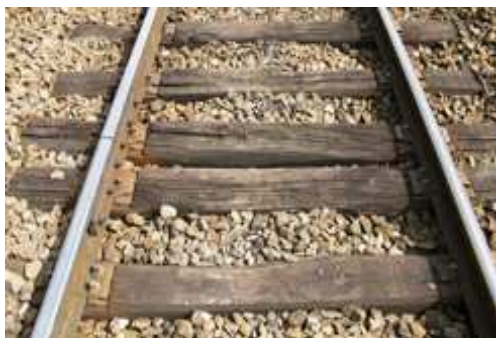
Figure 4 : Rails courts sur traverses bois
