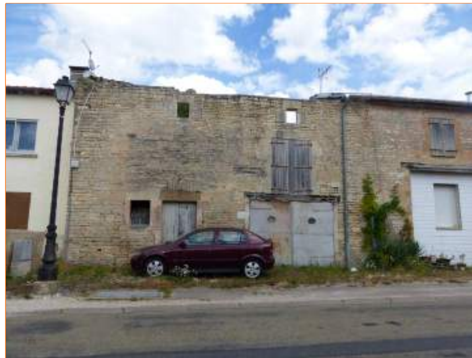
Bâti à l'abandon
