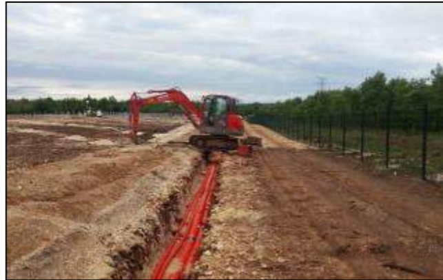
Enfouissement des réseaux
