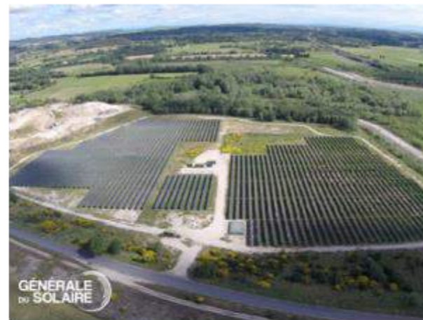
Centrale de Pujot, Gard
