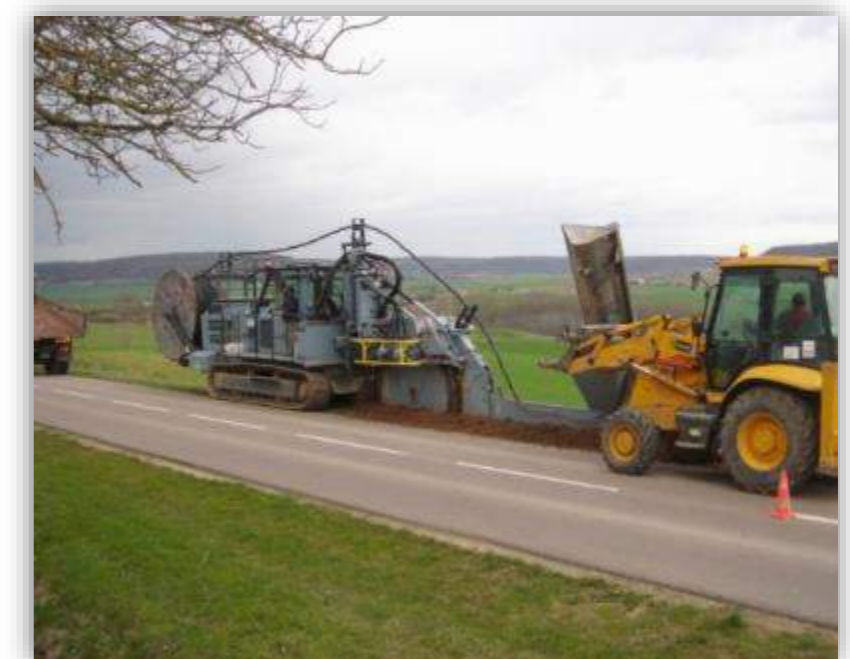
Réalisation de la tranchée
