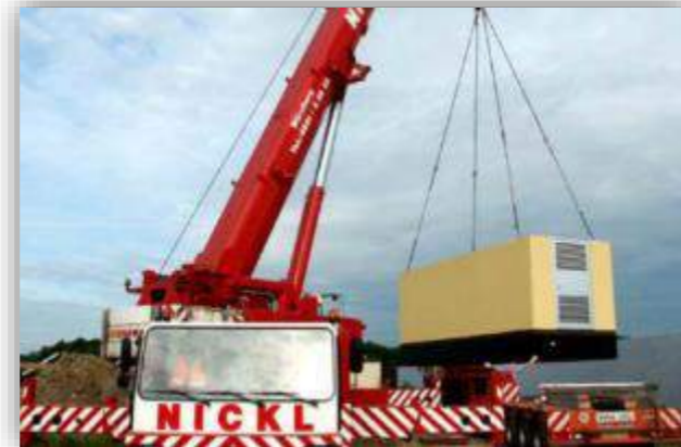
Exemple d'acheminement d'un poste technique préfabriqué
