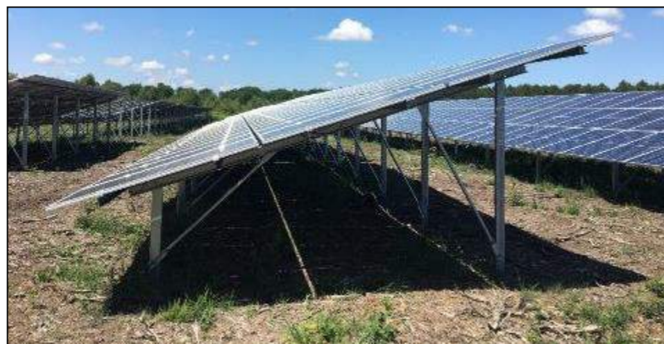
Exemple de structure de tables fixes
