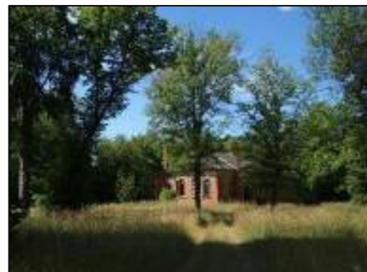
Bâtiment Sud-Ouest ; Photo : S. Bellour
