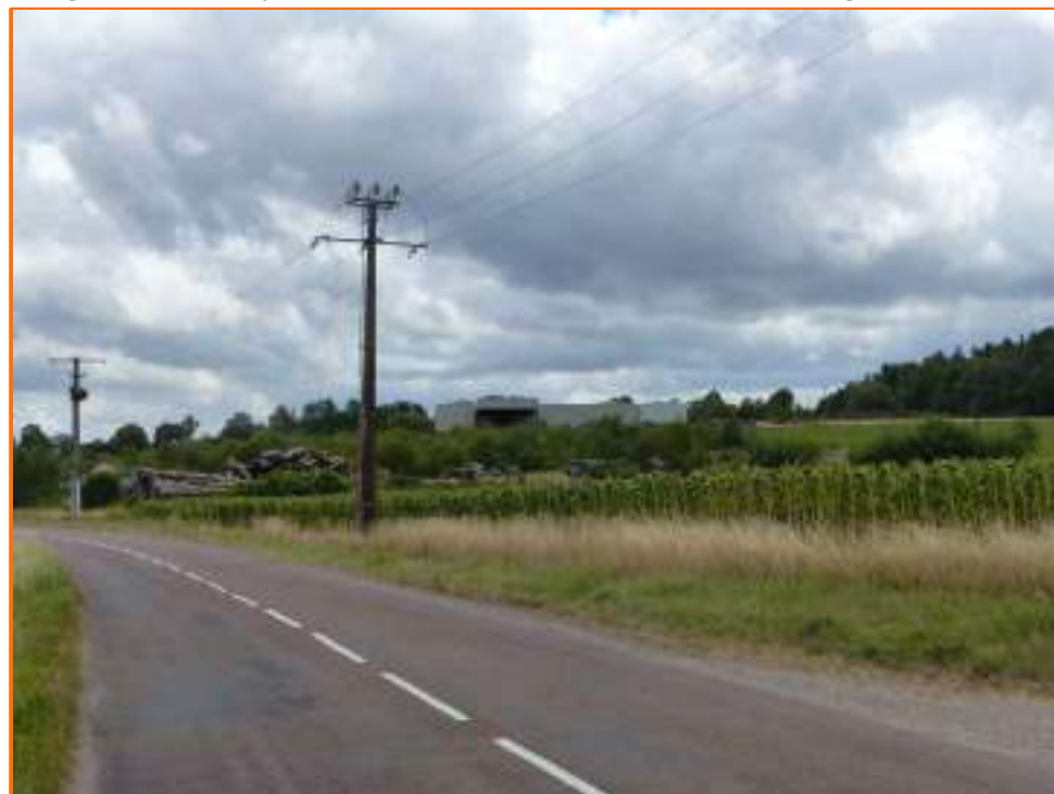
Lignes électriques, bâtiments industriels et stockages de bois
