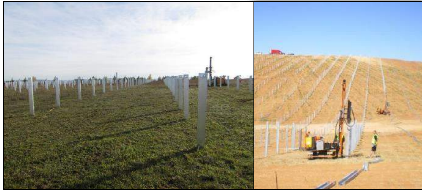
Exemple de pieux battus dans le sol avec une batteuse visible en arrière-plan
