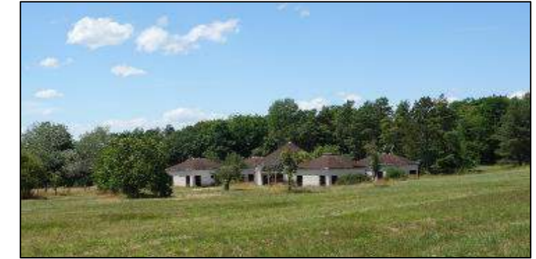
Bâtiment Nord ; Photo : S. Bellour
