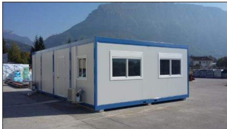
Exemple d'une base-vie
