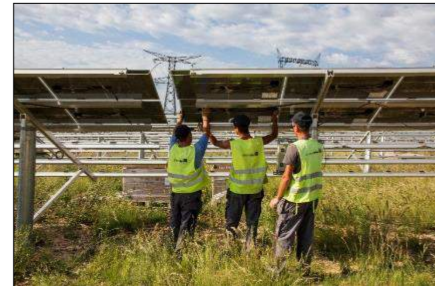
Pose de modules
