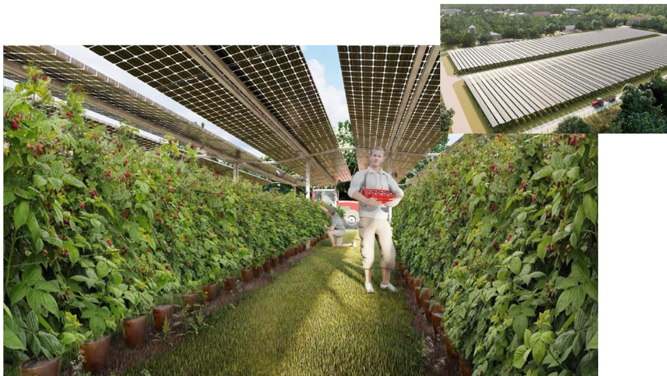
Figure 23 – Illustration de l’implantation des framboisiers sous des panneaux en plein sur Rimaucourt (Source : PHOTOSOL)
