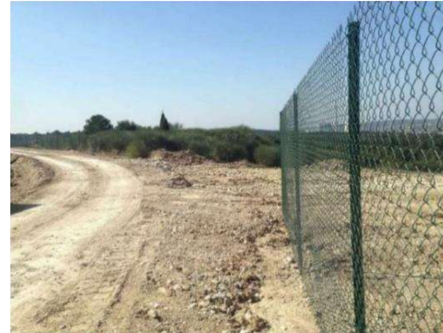
Photo 6 : Exemple de clôture et voie d'accès sur une centrale photovoltaïque (© Opale)
