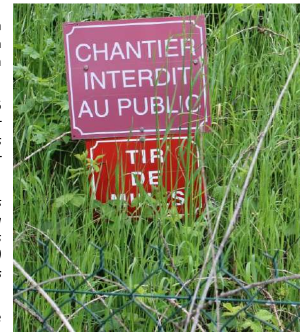
Figure 109 : Panneau de signalisation du risque « tir de mines »
