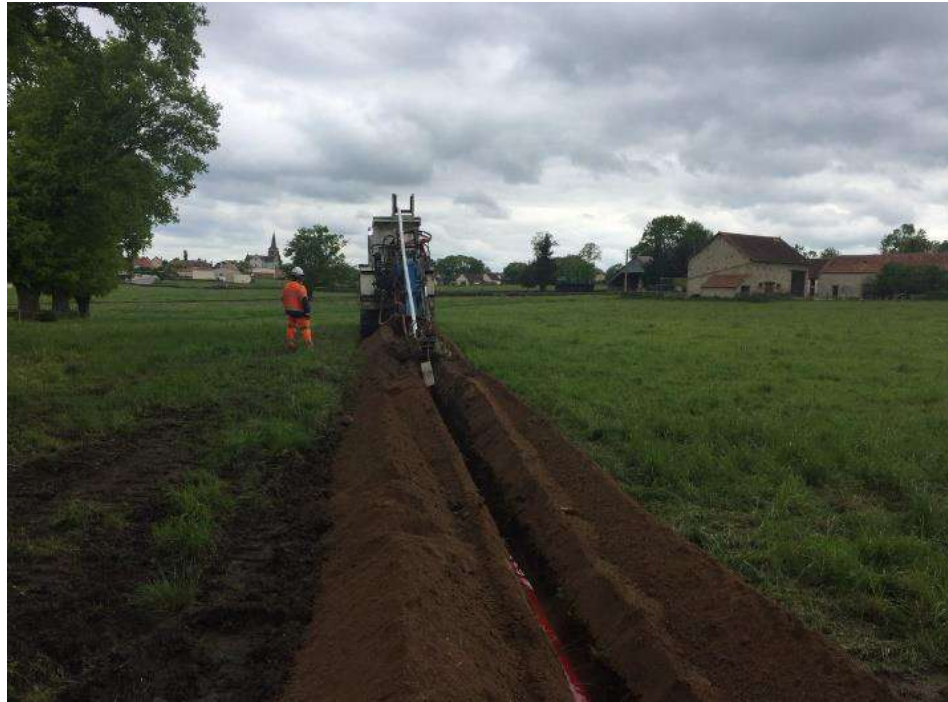
Exemple de trancheuse pour enterrer les câbles électriques
