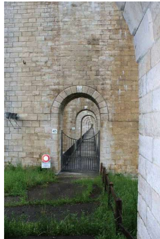
Le premier étage du viaduc, actuellement fermé au public en raison de travaux
