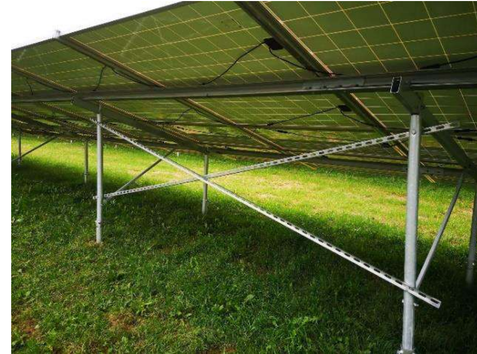
Photo 1 : Exemple d'ancrage par pieux battus ou vissés (© Opale)
