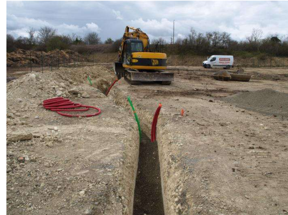
Exemple de pose de fourreaux
