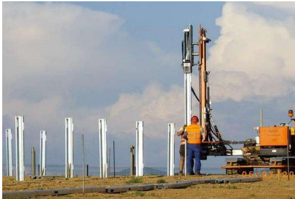
Pose de pieux battus pour ancrer les tables photovoltaïques
