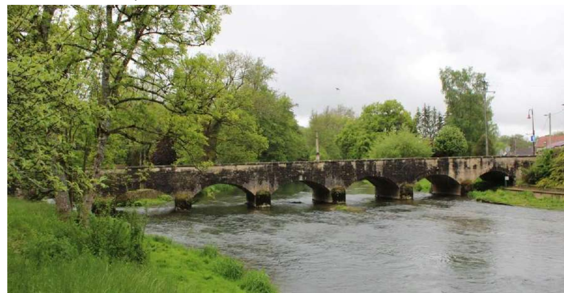
26-Pont enjambant la Marne / Condes
