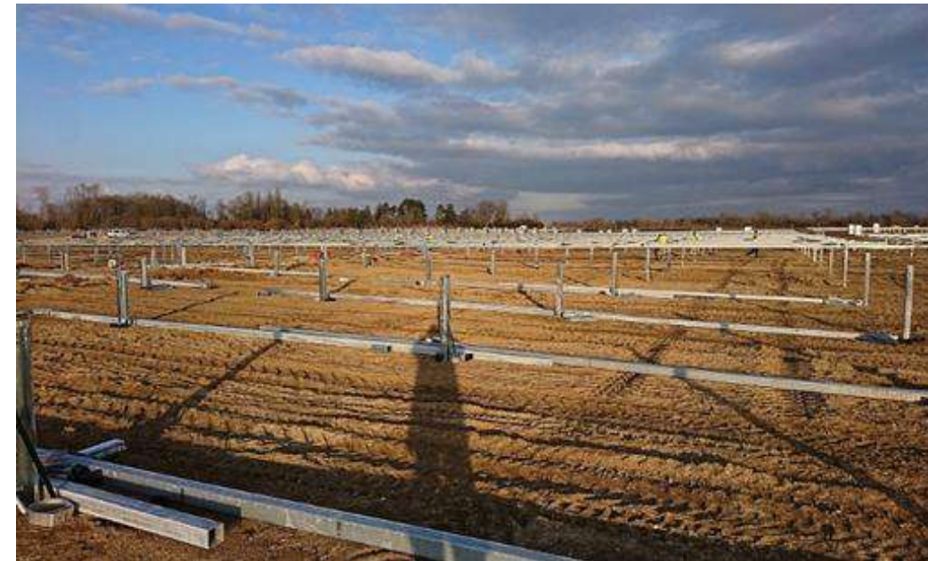
Pose de pieux battus pour ancrer les tables photovoltaïques
