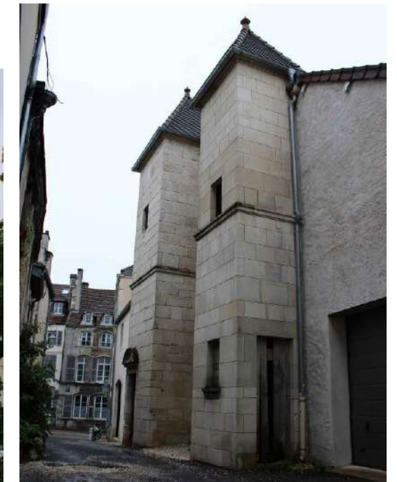
19-Maison 1 rue Jean Gouthière / Chaumont
