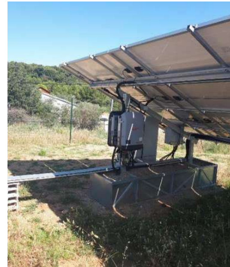
Photo 2 : Exemple de lestage par gabion (© Opale)
