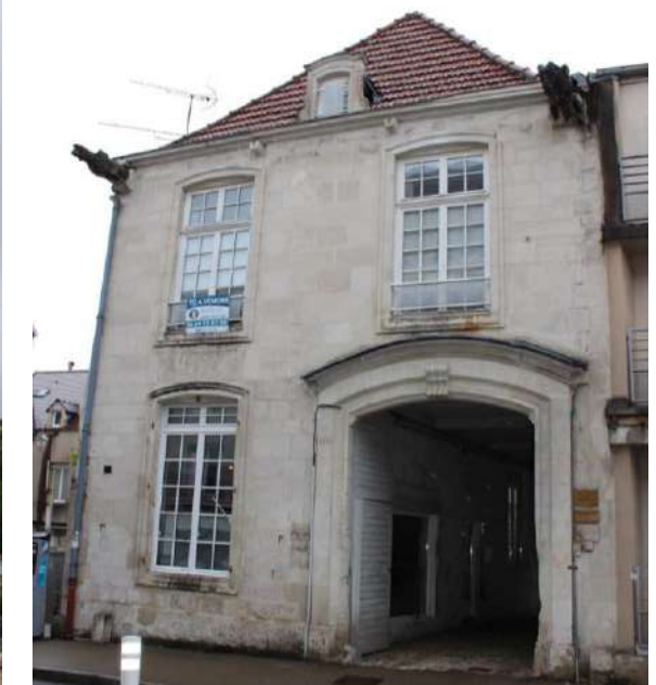
3-Immeuble 15 rue Jules Tréfousse / Chaumont
