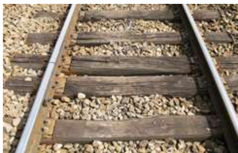
Rails courts sur traverses bois
